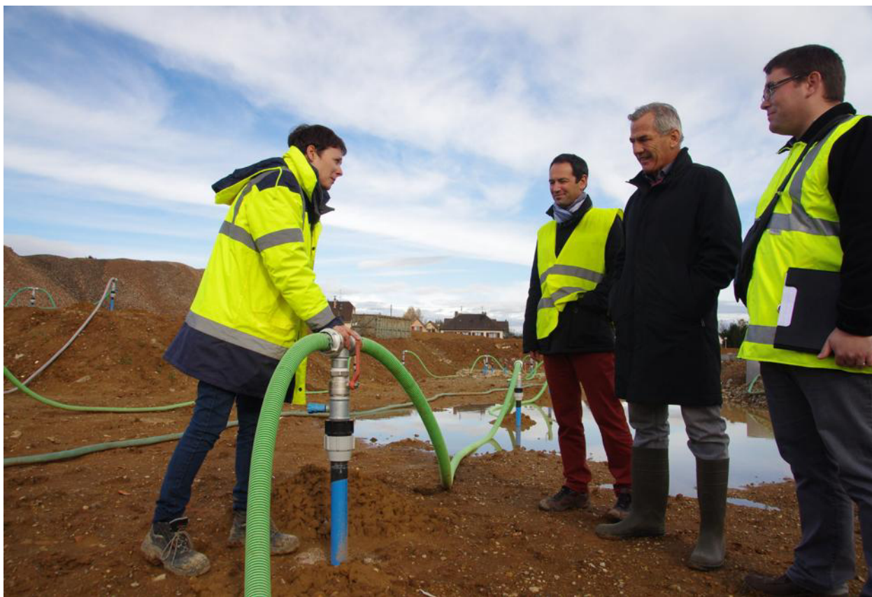
24 puits ont été mis en place pour aspirer l'air pollué contenu dans la terre et éviter de l'excaver. Une technique plus longue mais qui ne retarde pas les projets de Bernard Stoeffler (2 ème à partir de la droite). PHOTO DNA
