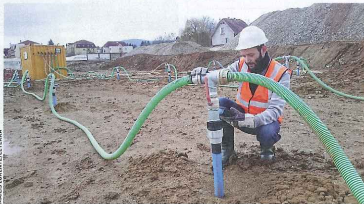
Mesure des gaz du sol par la société Cétterra après traitement par «venting».
